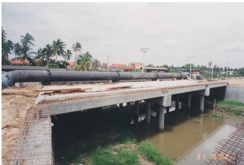
รูปที่ 4-12 เสาตอม่อตบริมและเสาสะพาน
