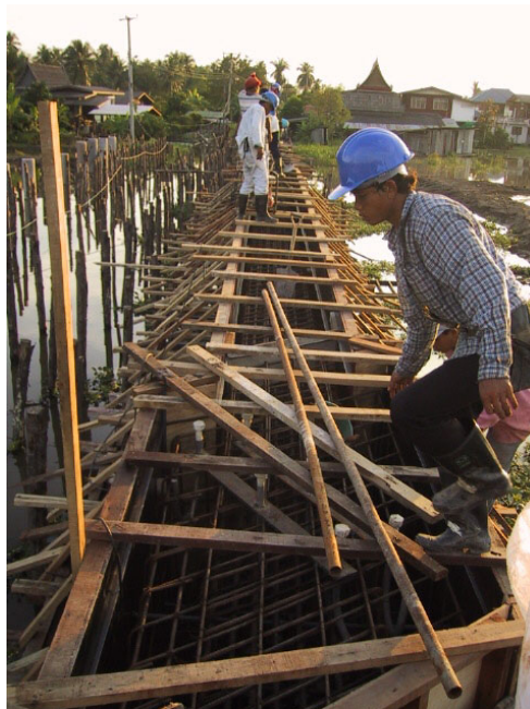
รูปที่ 4-8 การตรวจสอบแบบหล่อคอนกรีตให้อยู่ตามแบบก่อสร้าง
