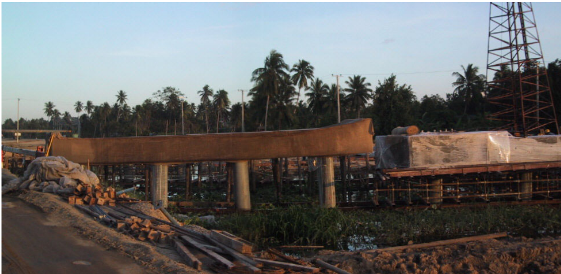
รูปที่ 4-7 การบ่มคอนกรีตโดยใช้กระสอบหรือพลาสติก
