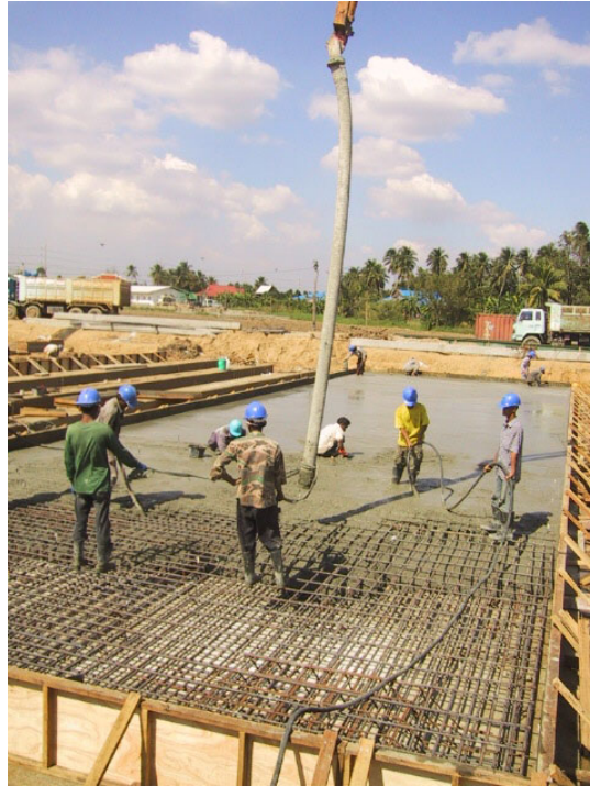
รูปที่ 4-6 การเทคอนกรีตพื้นสะพาน
