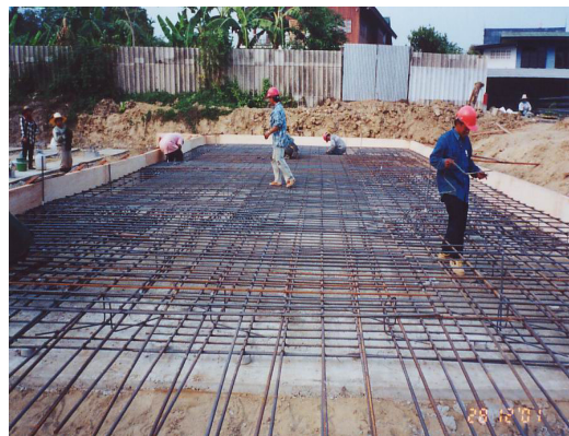
รูปที่ 4-15 การผูกเหล็กและการหล่อแผ่นพื้นสะพาน
