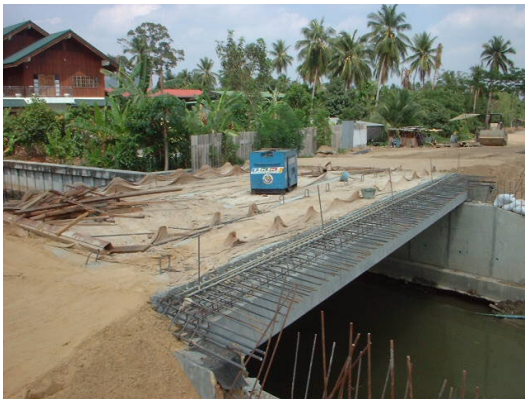
รูปที่ 4-15 การผูกเหล็กและการหล่อแผ่นพื้นสะพาน
