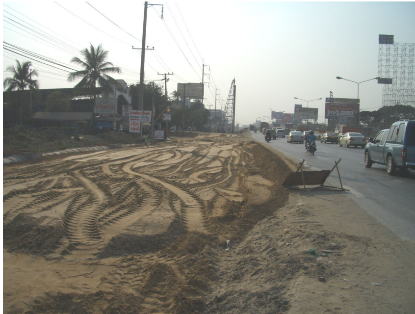
รูปที่ 4-17 งานถมทรายและบดอัดบริเวณคอสะพาน
