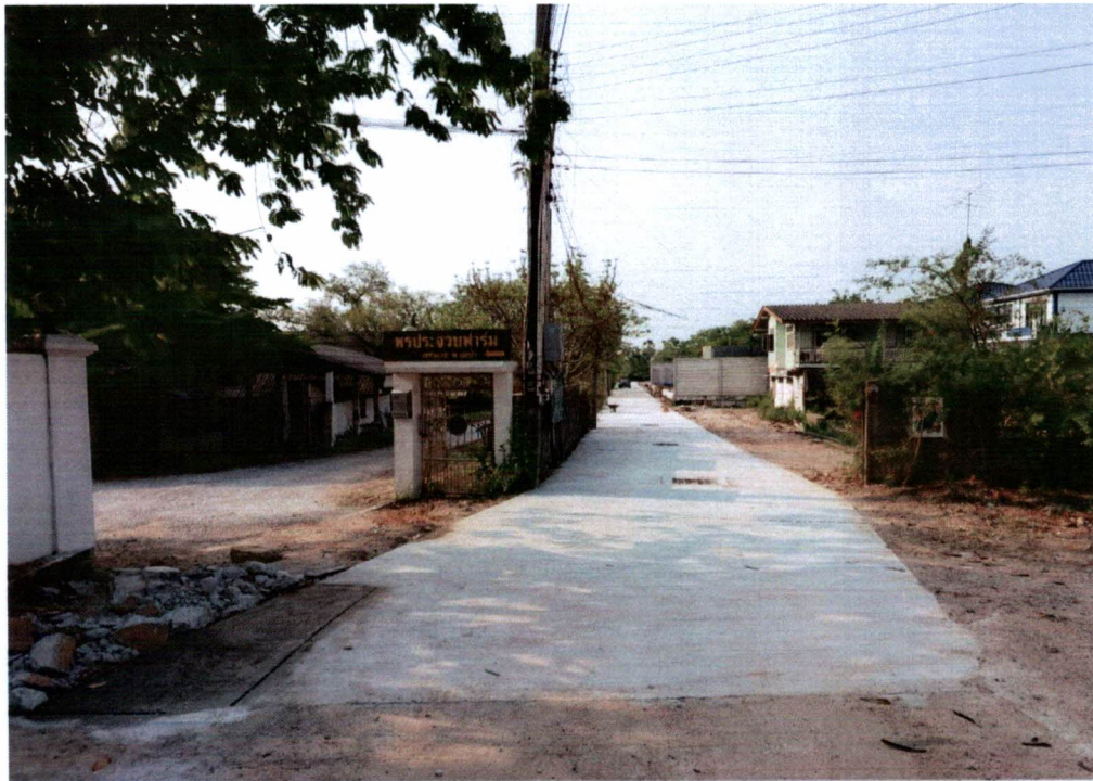
รูปหลังดำเนินงานก่อสร้างถนน ค.ส.ล. พร้อมวางท่อระบายน้ำ บริเวณซอยพรประจวบฟาร์มต่อจากของเดิม ม.๑๒
