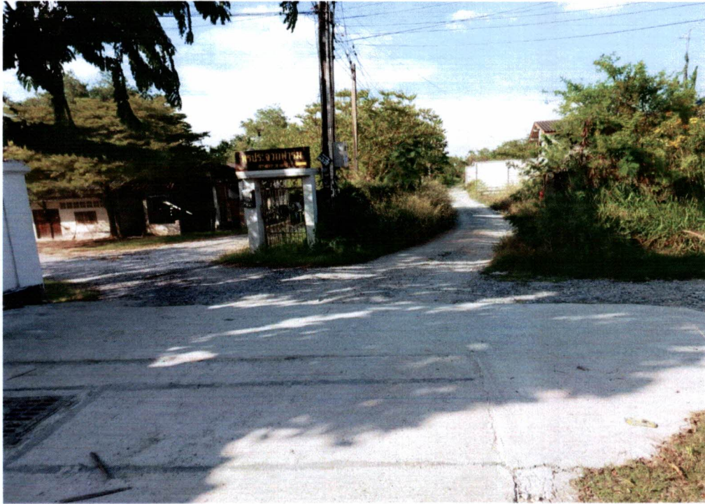
รูปก่อนดำเนินงานก่อสร้างถนน ค.ส.ล. พร้อมวางท่อระบายน้ำ บริเวณซอยพรประจวบฟาร์มต่อจากของเดิม ม.๑๒
