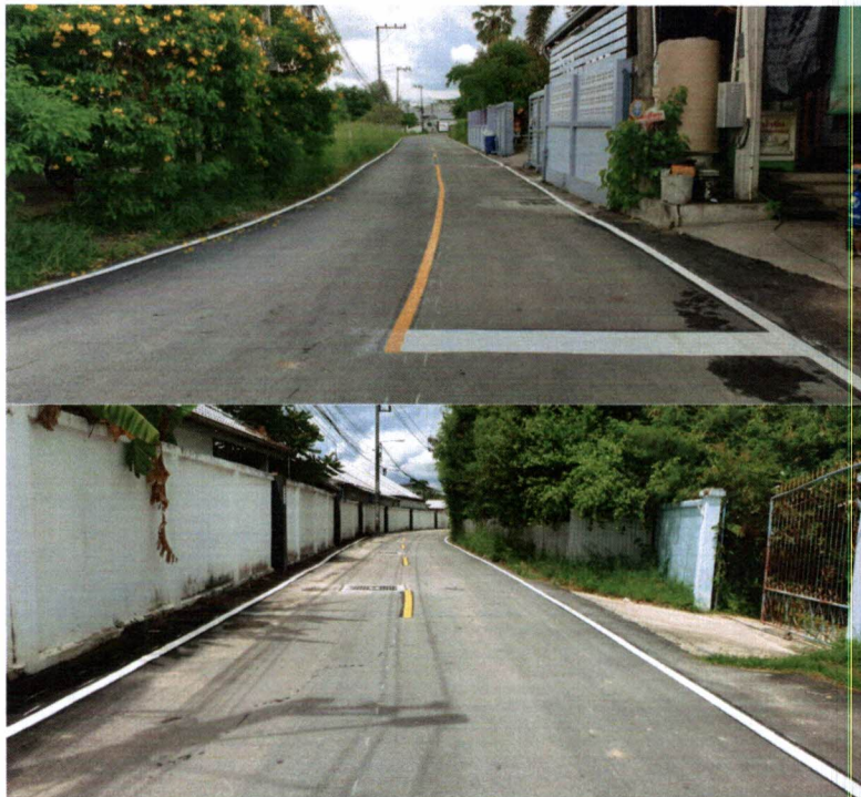
รูปหลังดำเนินงานโครงการก่อสร้างถนนแอสฟัลท์ติกคอนกรีต บริเวณซอยโรงกาว ม.๕ ต.นาป่า
