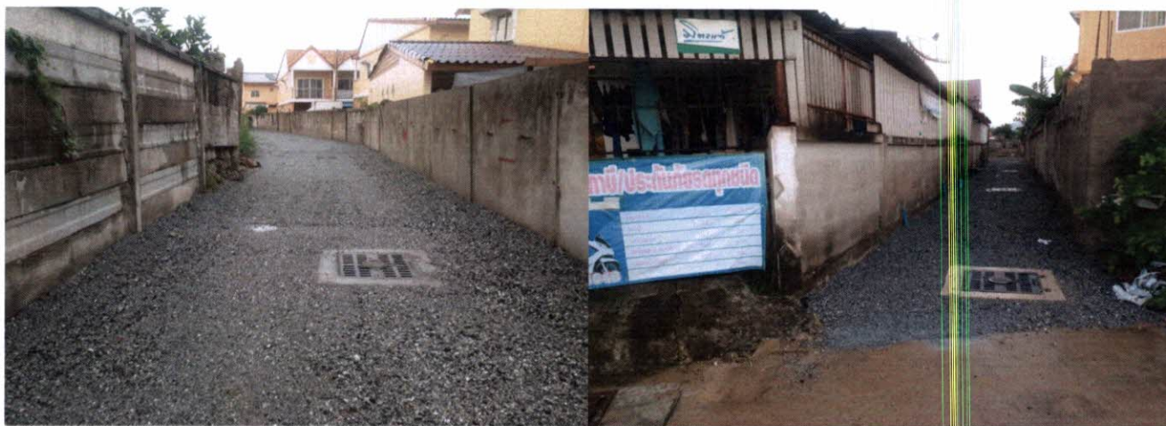
รูปหลังดำเนินงานแล้วเสร็จงานก่อสร้างถนนหินคลุก พร้อมวางท่อระบายน้ำ บริเวณหลังหมู่บ้านวรัญญาเชื่อมถนนตำบลดอนหัวฬ่อ ม.๔ ต.นาป่า
